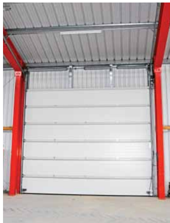
Die Tore sind 5,40 m breit. Der Abstand zwischen den einzelnen Bindern liegt bei 6 m.
