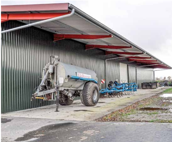
Die Halle mit einem fünf Meter breiten Vordach: Ideal, um schnell etwas unterzustellen, um es vor der Witterung zu schützen.
