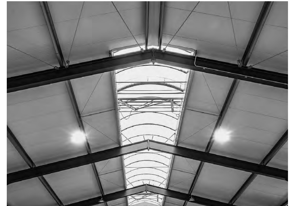
Ein Lichtkuppelfirst ist 2,5 m breit und 18 m lang.
