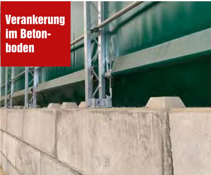
Für die Verankerung im Betonboden werden chemische Dübel, die speziell für die Montage von Hallenkonstruktionen geeignet sind, eingesetzt.
