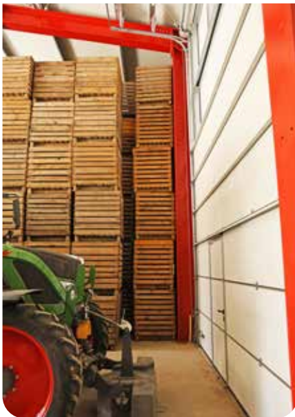
Die besondere E.L.F.-Rahmenecke baut extrem platzsparend auf. Somit werden Energiekosten bei der Kühlung gespart.
